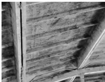
а) Следы замачивания плит покрытия
