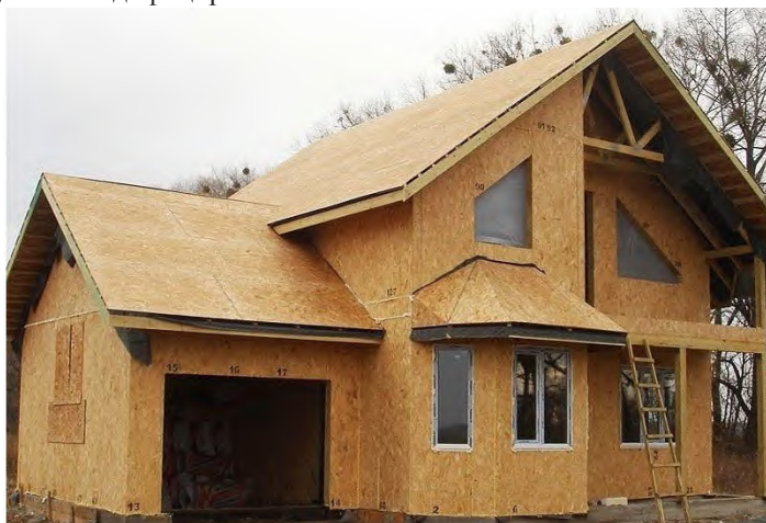
Рис. 1. Малоэтажное здание из сэндвич-панелей и облегченных конструкций
