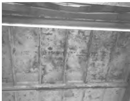
б) Шелушение бетона плит покрытия
